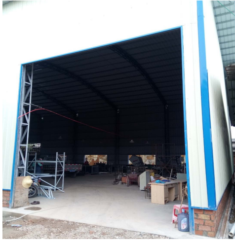
生产车间现状
