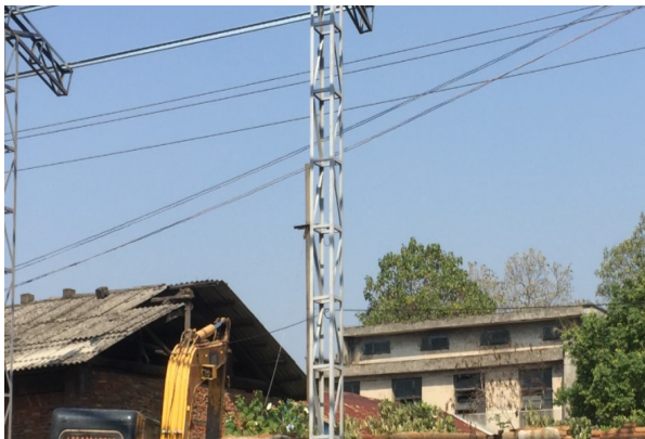
项目北侧 闲置厂房
