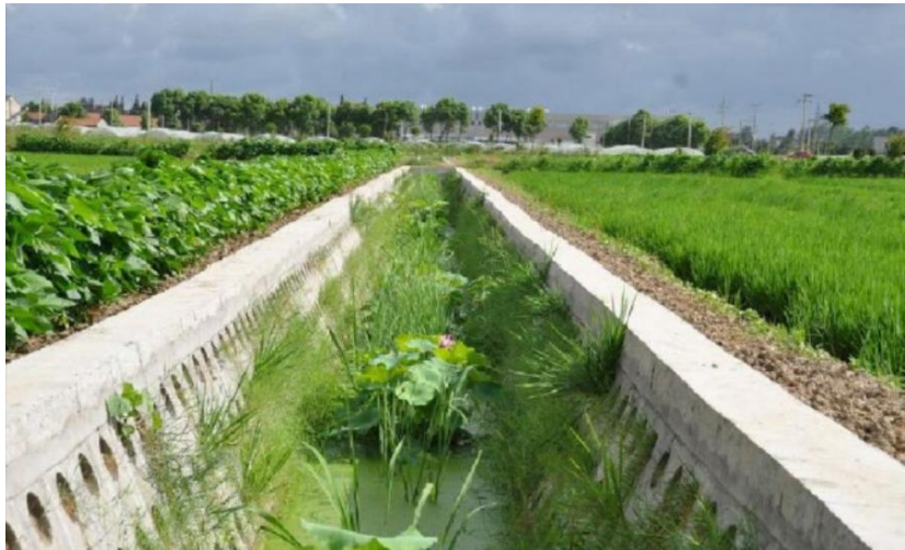
图 2-3 生态沟渠示意图
